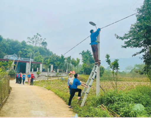
Đoàn viên, thanh niên xã Chiêm Hóa lắp đặt hệ thống đèn chiếu sáng tại thôn Hòa Đa.
