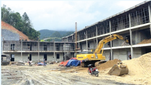
Trường Phổ thông Nội trú liên cấp Tiểu học và THCS Thanh Thủy đạt hơn 45% khối lượng thi công.
