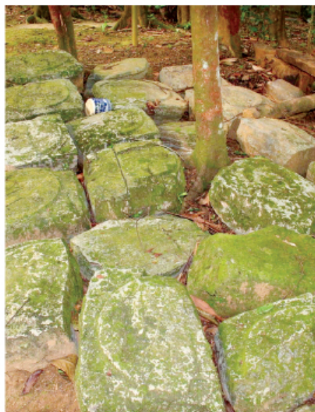
Những pho tượng Phật cổ tại chùa Phúc Lâm Tự (ảnh trái); Đá kê cột là những phiến đá tự nhiên được gia công, chế tác theo những hình dạng khác nhau để kê cột (ảnh phải).
