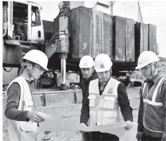
Dự án công trình Trung tâm thương mại GO! Tuyên Quang đang được nhà thầu thi công bám sát biểu đồ tiến độ.
