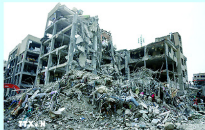
Một tòa nhà bị phá hủy sau vụ không kích xuống Tehran, Iran.
