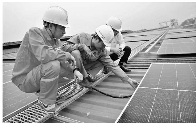
Công ty Giấy An Hòa lắp đặt điện mặt trời mái nhà.
