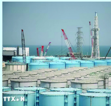
Các bể chứa nước thải nhiễm xạ tại Nhà máy Điện hạt nhân Fukushima Daiichi ở Okuma, tỉnh Fukushima, Nhật Bản.
