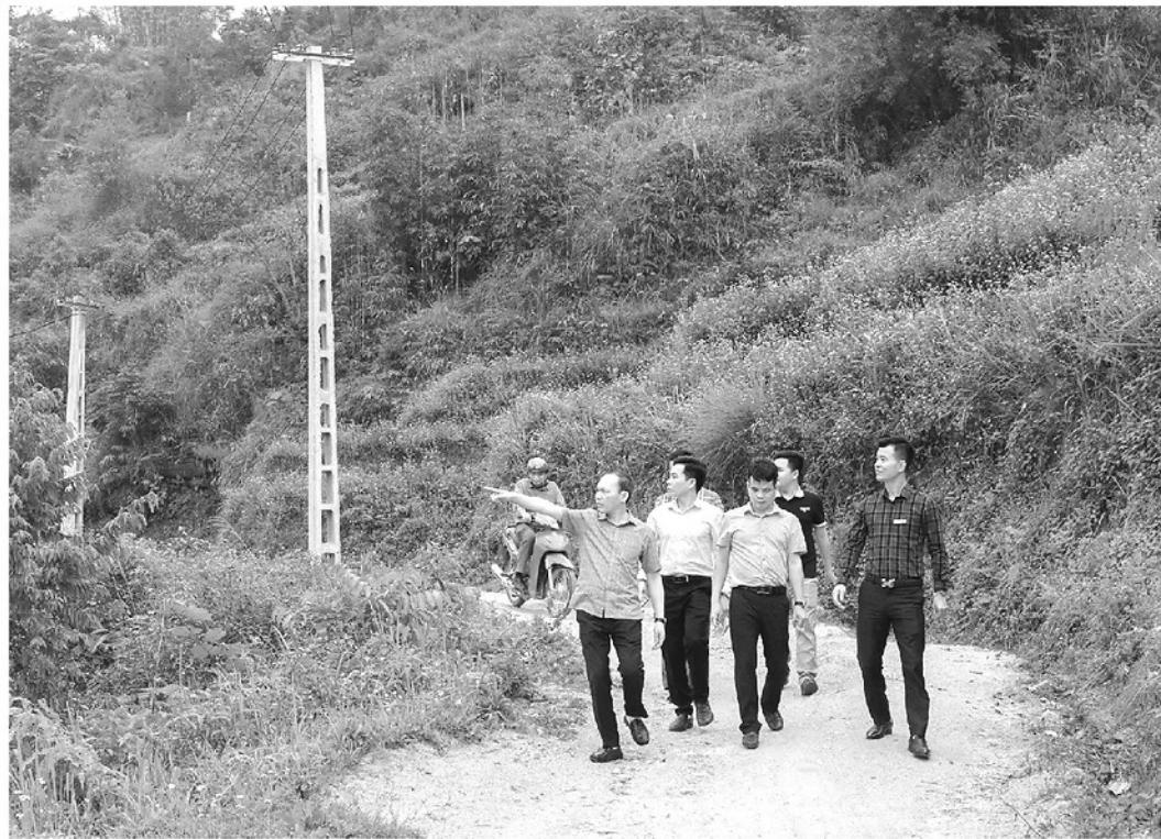
Đổng chí Nguyễn Văn Dung, Giám đốc Sở Dân tộc và Tôn giáo cùng Đoàn công tác kiểm tra, khảo sát công trình điện tại xã Nấm Dẩn.
