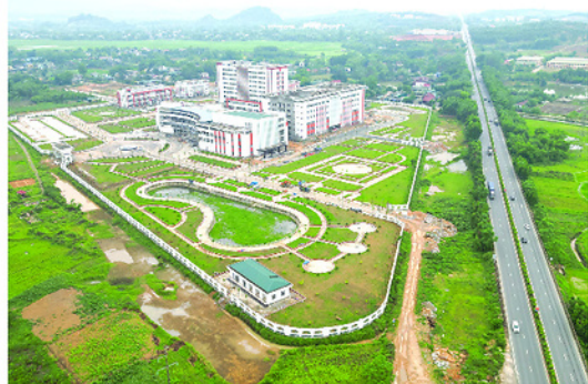
Dự án Bệnh viện Đa khoa tỉnh Tuyên Quang quy mô 1.000 giường bệnh tại phường An Tường đang được các nhà thầu thi công gấp rút hoàn thiện giai đoạn cuối.
