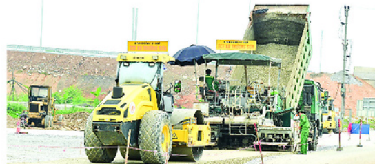
Các nhà thầu tập trung phương tiện, máy móc làm việc 3 ca 4 kíp, bảo đảm tuyến Cao tốc Tuyên Quang - Hà Giang về đích đúng dự kiến.
