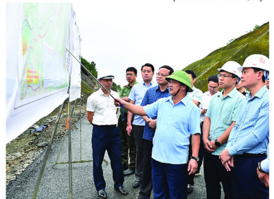
Đồng chí Bí thư Tỉnh ủy Hàu A Lệnh kiểm tra tiến độ thi công tuyến đường cao tốc đoạn qua xã Bắc Quang.
