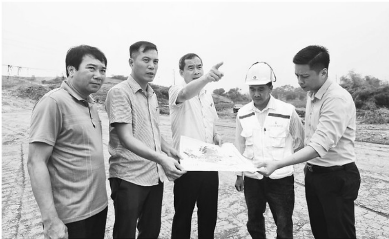
Lãnh đạo phường Mỹ Lâm nắm tình hình thi công các công trình trọng điểm qua địa bàn.
