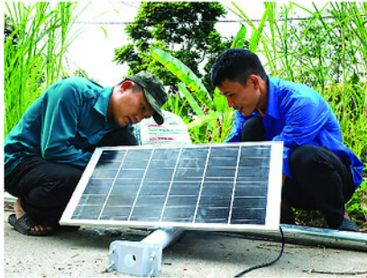
Chung sức hoàn thiện công trình “Thắp sáng đường quê” bằng nguồn năng lượng xanh.
