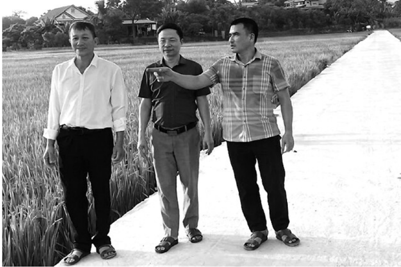
Bí thư Chi bộ, Trưởng thôn An Ninh, xã Trường Sinh - Thạch Văn Tuấn (ngoài cùng, bên trái) kiểm tra tuyến đường bê tông vừa đưa vào sử dụng.
