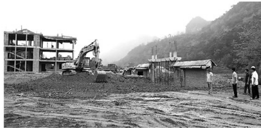
Trường Phổ thông Nội trú liên cấp TH&THCS Thanh Thủy có tiến độ thi công nhanh nhất, hiện đã đạt trên 70% khối lượng công trình.
