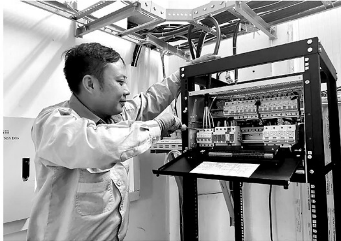
Tập đoàn Viễn thông Quân đội - Viettel lắp đặt trạm 5G để nâng cao chất lượng phát sóng.
