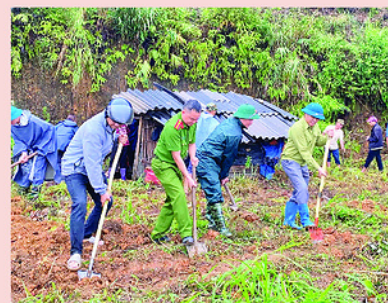
Khởi công xây dựng nhà cho bà Chánh Thị Lau, thôn Phiêng Đé, xã Mậu Duệ tỉnh Tuyên Quang.
