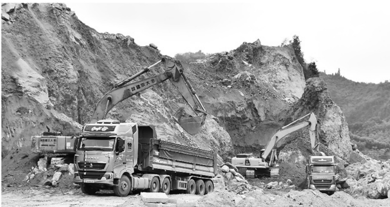
Đơn vị thi công đang dọn dẹp thi công khu tái định cư Trung Sơn thuộc Dự án đường Hồ Chí Minh đoạn Chợ Chu (Thái Nguyên) - Ngã ba Trung Sơn (Tuyên Quang).
