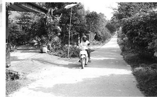
Tuyến đường liên thôn Khuổi Pâu, xã Tri Phú được bê tông hóa giúp người dân đi lại thuận tiện.
