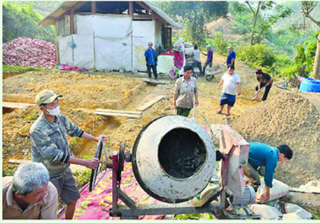
Khởi công xây dựng nhà cho chị Phùng Thị Như Quỳnh, thôn Đồng Đi, xã Kiến Thiết.
