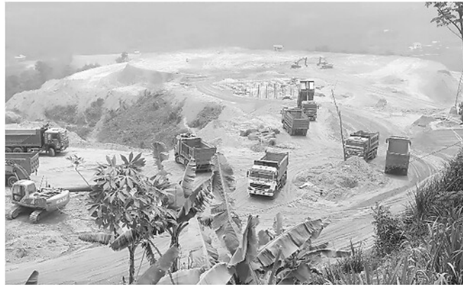
Công trường Dự án ổn định dân cư khẩn cấp thôn Cốc Pú - Nàn Ma được đẩy nhanh tiến độ để sớm ổn định nơi ở cho người dân vùng sạt lở.
