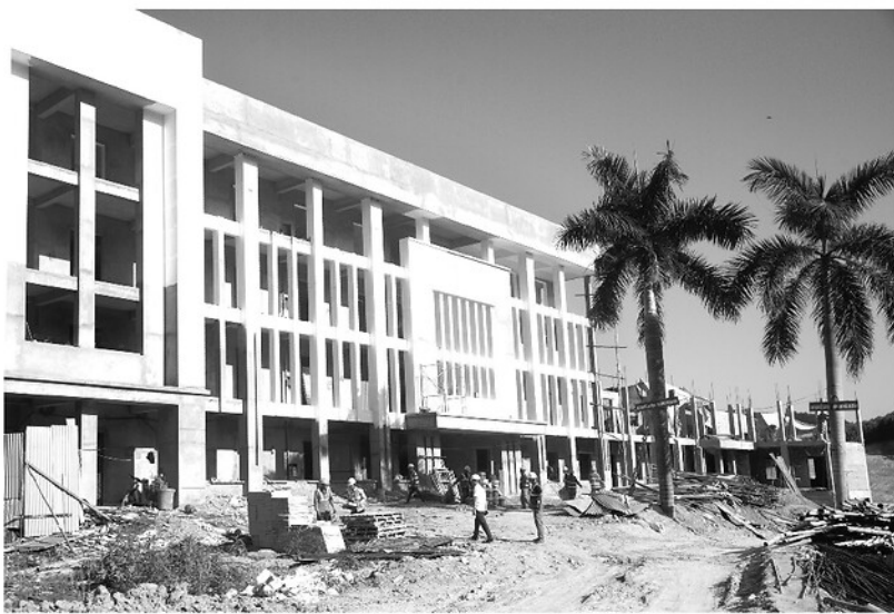
Công trình trường THCS Trung Sơn, xã Trung Sơn đang được đẩy nhanh tiến độ thi công.
