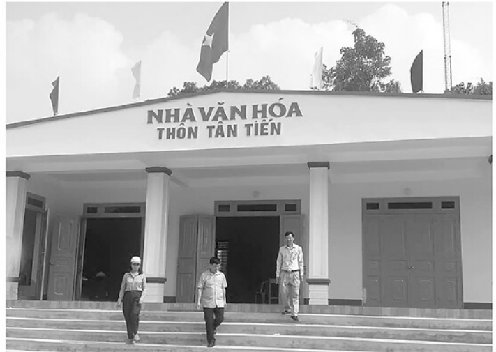
Nhà Văn hóa thôn Tân Tiến, xã Minh Thanh được đầu tư từ Chương trình mục tiêu Quốc gia xây dựng nông thôn mới.
