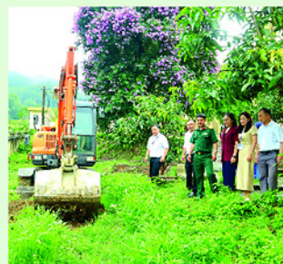
Khởi công công trình cung cấp nước sinh hoạt cho học sinh xã Yên Minh.
