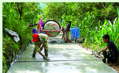
Người dân thôn Sùng Sủ A bê tông hóa giao thông nông thôn.
