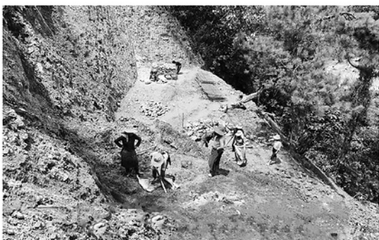
Công ty cổ phần Đường bộ I - Hà Giang đang thi công khắc phục điểm sạt lở Quốc lộ 34.
