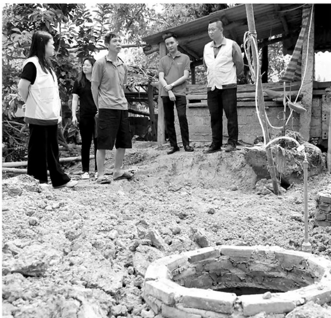
Dự án "Năng lượng xanh từ chăn nuôi" tại xã Bằng Lang lắp đặt bể biogas cho các hộ nuôi lợn.
