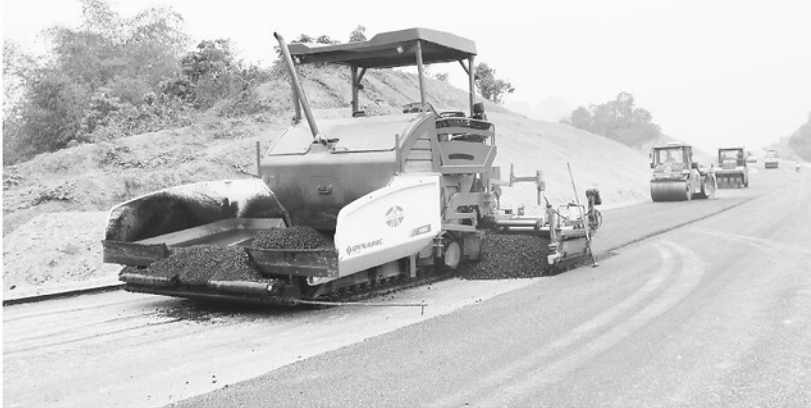
Tuyến Cao tốc Tuyên Quang - Hà Giang (giai đoạn 1) đang được đẩy mạnh hoàn thiện, công trình trọng điểm do Ban Quản lý dự án công trình số 1 của tỉnh làm chủ đầu tư.
