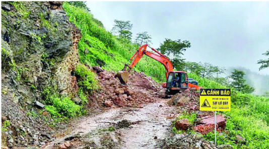
Xã Đồng Văn nhanh chóng sửa chữa các tuyến đường bị sạt lở, đảm bảo giao thông thuận lợi trong mùa mưa bão.
