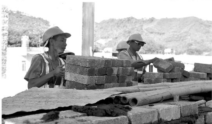
Công nhân Công ty Cổ phần Tư vấn và Đầu tư xây dựng Phúc Lợi nỗ lực thi công trên công trường xây dựng Trường THCS Trung Sơn, xã Trung Sơn.
