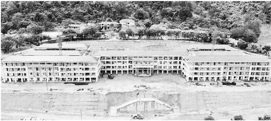
Dự án Trường Phổ thông Nội trú liên cấp Tiểu học và Trung học cơ sở Phong Thổ, tỉnh Lai Châu đang được gấp rút hoàn thiện.
