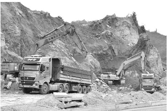
Đơn vị thi công đang dồn sức thi công khu tái định cư Trung Sơn thuộc Dự án đường Hồ Chí Minh đoạn Chợ Chu (Thái Nguyên) - Ngã ba Trung Sơn (Tuyên Quang).
