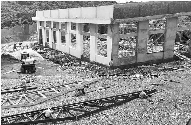
Dự án xây dựng Trường Nội trú liên cấp tại xã Sơn Vĩ dù thiếu nhân lực nhưng đang được nhà thầu tích cực thi công.
