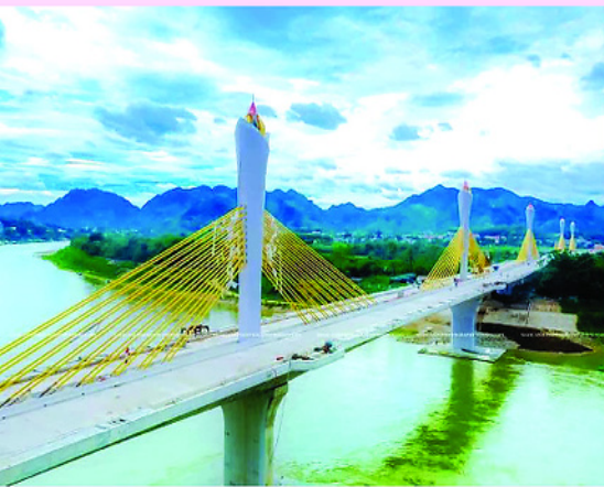
Sông Lô đoạn qua phường Nông Tiến, Tuyên Quang.
