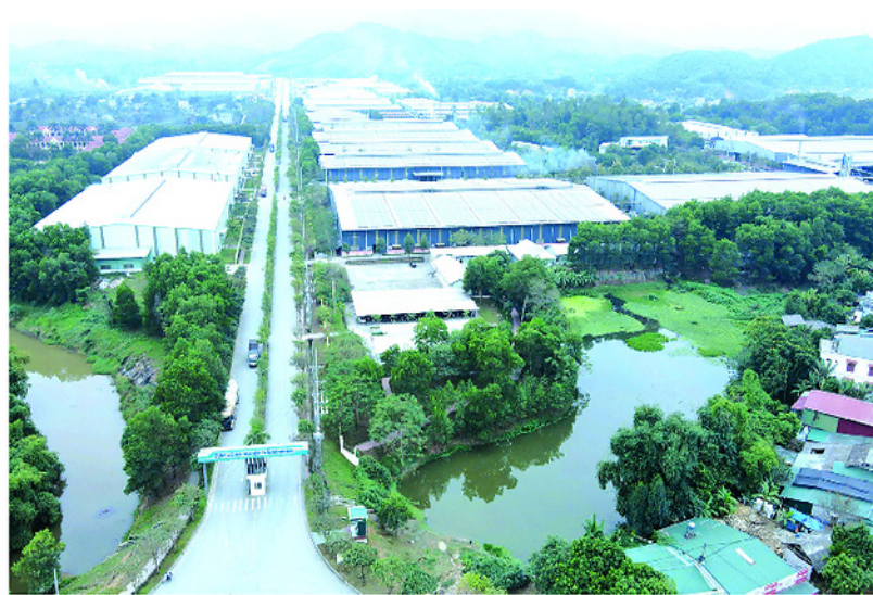
Cụm công nghiệp Thang Quân được đầu tư hạ tầng đồng bộ.
