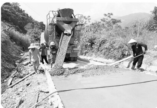
Xã Việt Lâm tập trung nguồn lực làm đường giao thông liên thôn.
