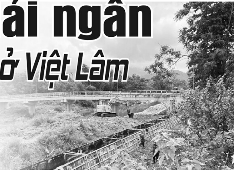
Công trình kè thôn Hát được xã Việt Lâm chỉ đạo đẩy nhanh tiến độ thi công.
