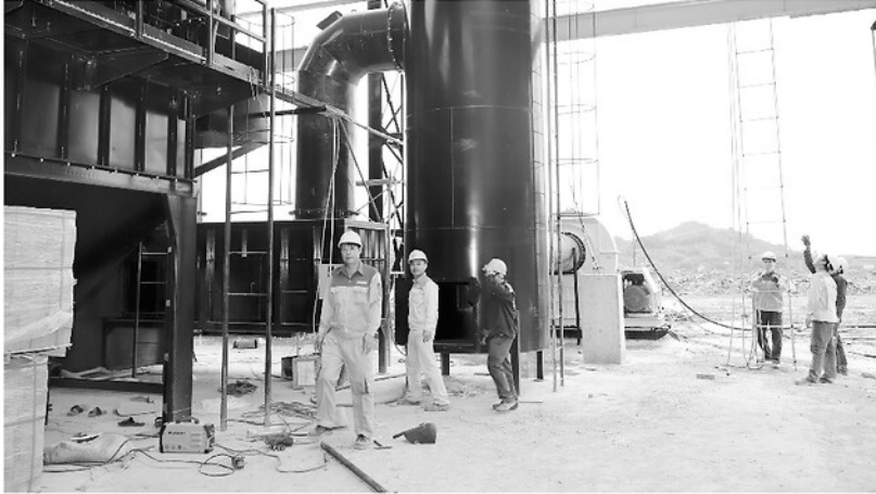
Nhà máy xử lý rác thải của Công ty Cổ phần Công nghệ môi trường HM Group trên địa bàn xã Nhữ Khê đang được đẩy nhanh tiến độ xây dựng.
