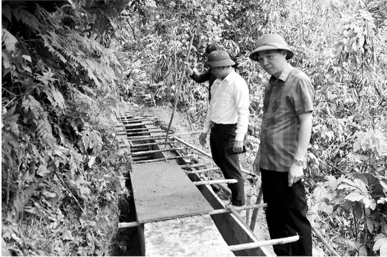
Lãnh đạo xã Bắc Mê kiểm tra tiến độ thi công, chất lượng công trình kênh mương tưới tiêu thôn Bản Noong.
