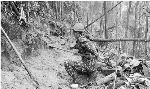
Đội thi công rà phá bom mìn, Bộ Chỉ huy Quân sự tỉnh thực hiện nhiệm vụ tại thôn Mã Hoàng Phìn, xã Minh Tân.
