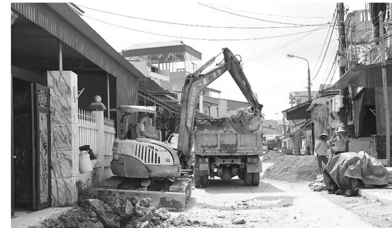
Công trình giao thông thôn Nà Khoang, xã Quân Bạ đang được đẩy nhanh tiến độ thi công và giải ngân vốn.
