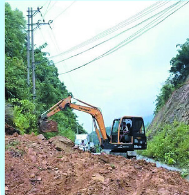
Huy động máy xúc dọn đất đá sạt lở, nhanh chóng khôi phục tuyến Tỉnh lộ 183 qua xã Bằng Lang.
