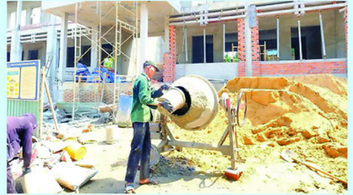
Các đơn vị đẩy nhanh tiến độ thi công Trường Tiểu học Đắc Á, xã Bù Gia Mập, thành phố Đồng Nai.
