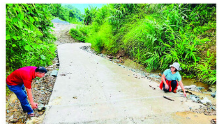
Đoàn giám sát đo chiều rộng mặt đường, đối chiếu với hồ sơ thiết kế được phê duyệt.
