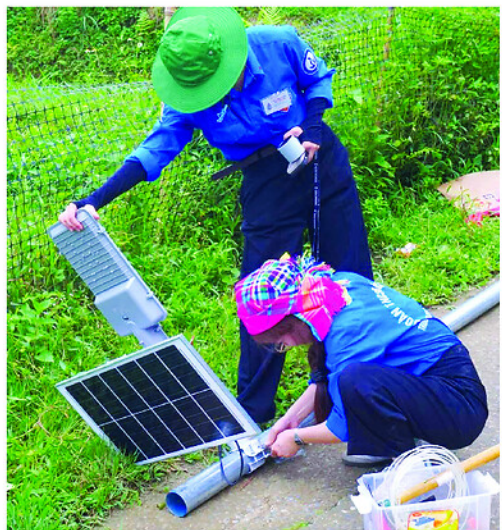
Đoàn viên xã Minh Sơn lắp đặt công trình “Thắp sáng đường quê” tại thôn Lũng Vầy.
