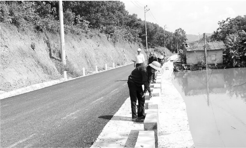
Tuyến đường ĐĐT 08 từ Km 39 đến ngã tư Đổng Bàng, Tân Yên (Hàm Yên) chuẩn bị bàn giao đưa vào sử dụng.
