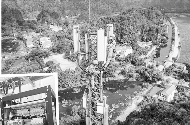
Các trạm phát sóng 4G, 5G mới được lắp đặt thay thế hạ tầng kỹ thuật 2G.
