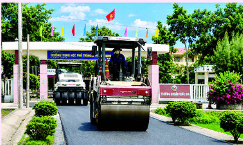
Trường THPT Lê Hồng Phong (Đắk Lắk) thăm nhựa tuyến đường dẫn vào trường.
