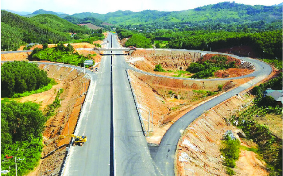
Nút giao Chân Sơn trên tuyến Cao tốc Tuyên Quang - Hà Giang (giai đoạn 1) đã thi công xong.
