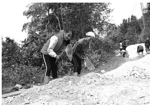
Người dân thôn Lũng Vải, xã Mèo Vạc chung sức làm đường bê tông nông thôn.
