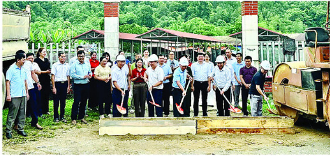
UBND xã Đồng Tâm khởi công Dự án Nâng cấp tuyến đường từ cổng chợ đến Trường Mầm non.
