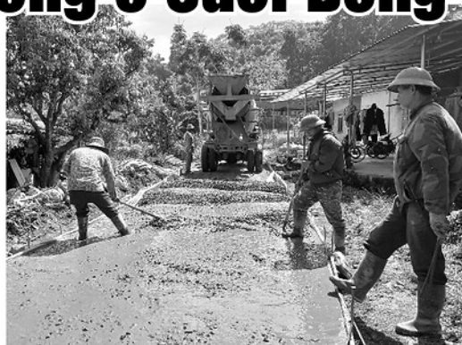
Nhân dân thôn Suối Đồng làm đường bê tông nông thôn.
