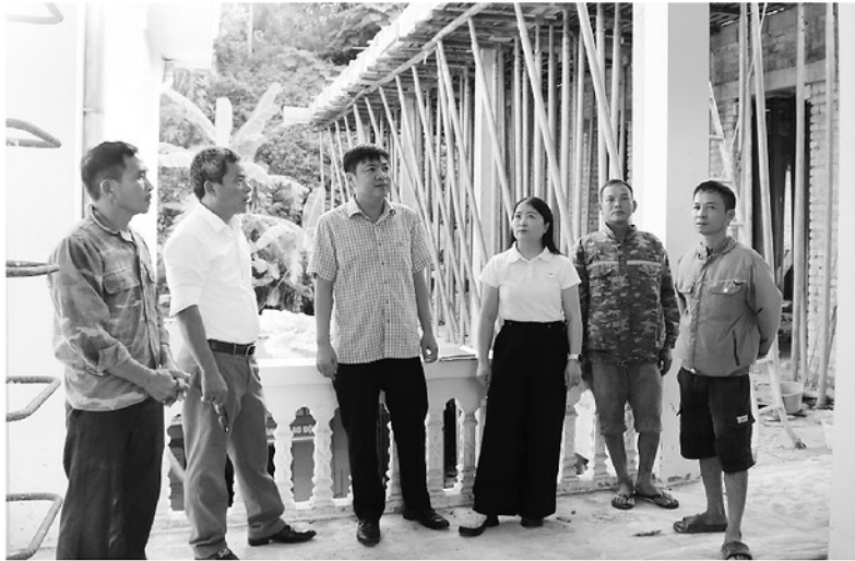
Lãnh đạo xã Chiêm Hóa kiểm tra tiến độ sửa chữa, nâng cấp điểm Trường Mầm non Ngọc Hộ.
