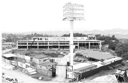
Siêu thị GO! Tuyên Quang đang được tập trung thi công phần đầu đưa vào hoạt động năm 2027.
