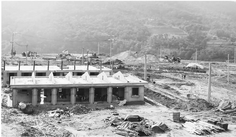
Dự án ổn định dân cư khẩn cấp tại thôn Cốc Pú đang được khẩn trương thi công.
